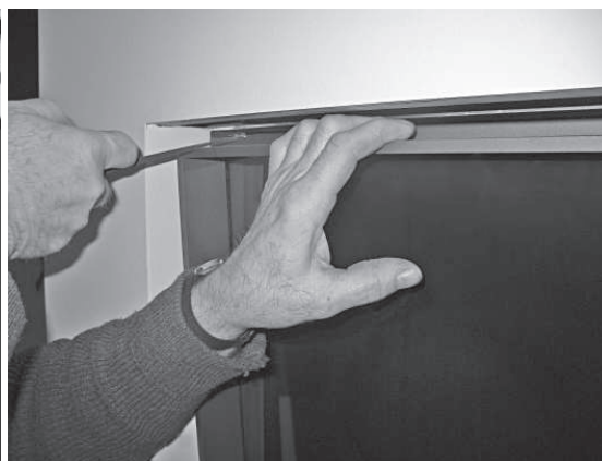
- Utilisez le Crochet fourni (voir photo) pour ouvrir le cadrage et accéder à la vitre.
