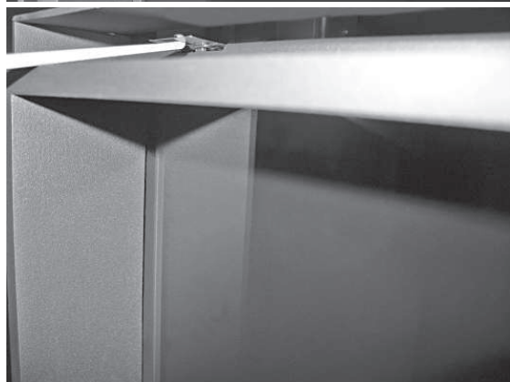
- En utilisant le crochet, retirer les bandes de ressort de métal à la gauche et à la droite des montants du cadrage.
