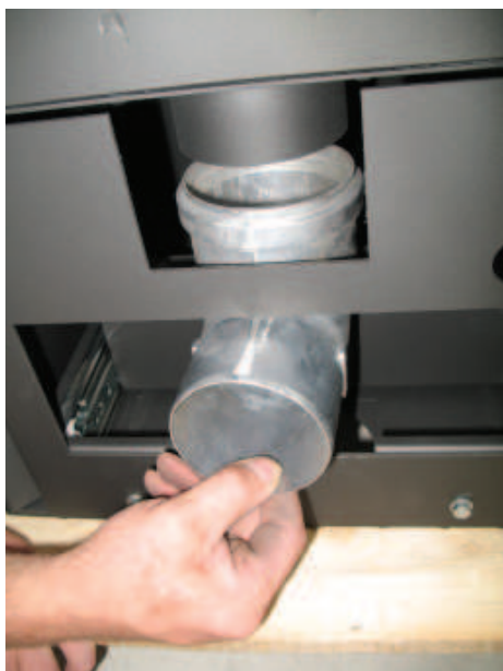
Raccordement vers l'arrière au moyen d'un coude 90° Ø80 mm
