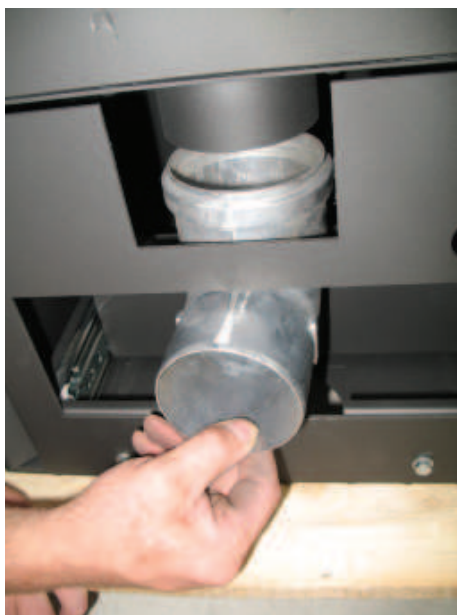
Aansluiting naar achter met behulp van een 90° bocht Ø80 mm
